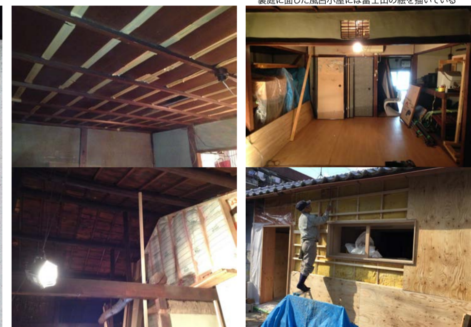
(上段)改修工事前写真 (下段)防音・断熱改修工事写真
