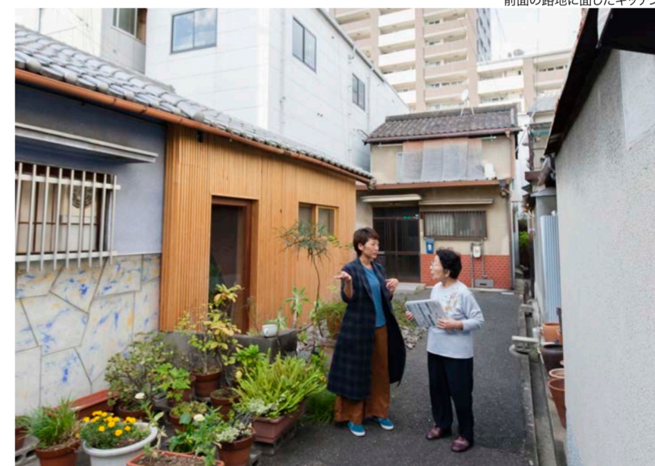
ファサードは断熱材を充填して板張りとしている 近隣路地コミュニティがまだ残る
