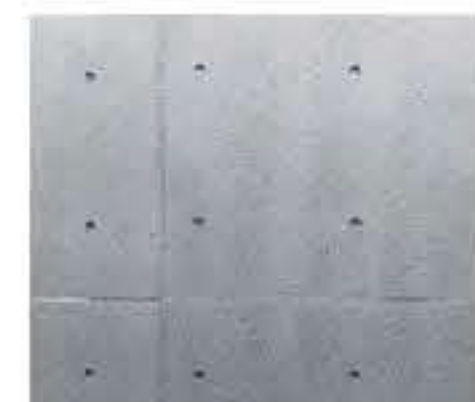
その他・外壁：コンクリート
