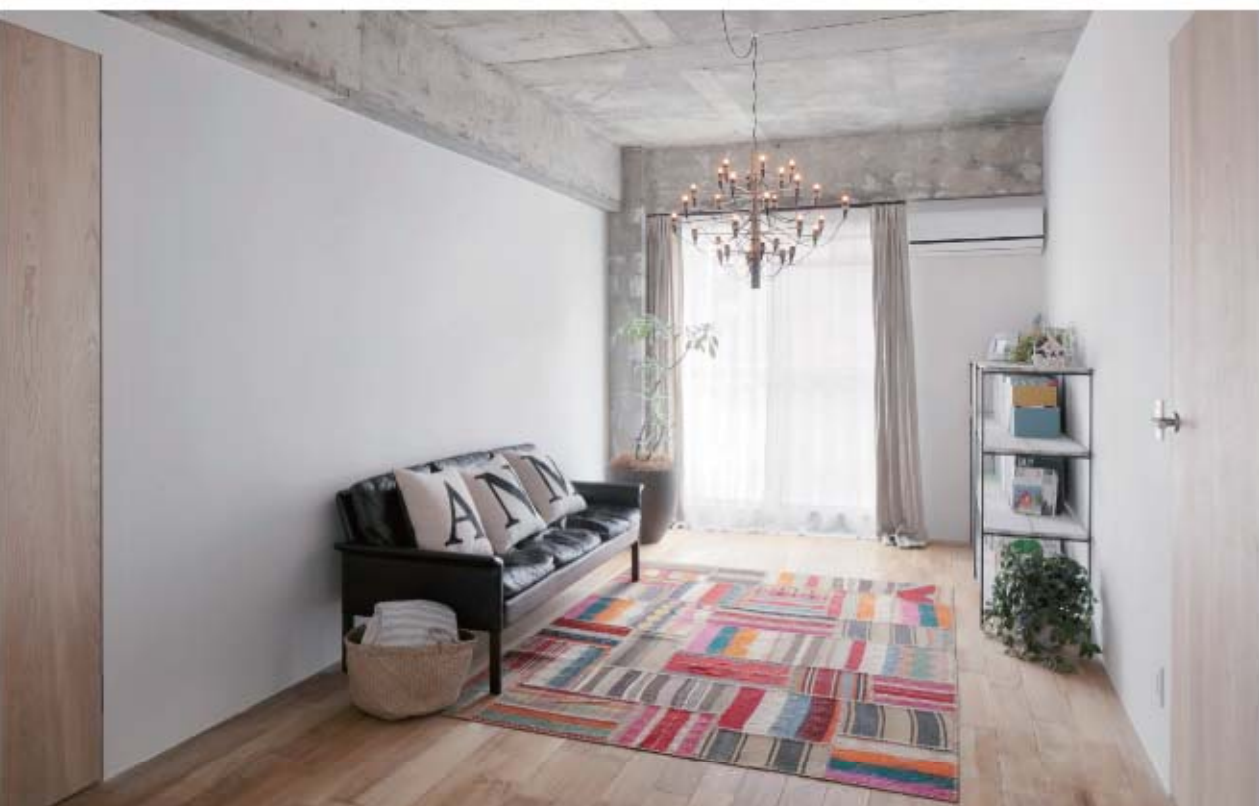
既存天井を取払い高さを確保し、カーテンで内と外を緩やかに繋げつつプライバシーを守る
