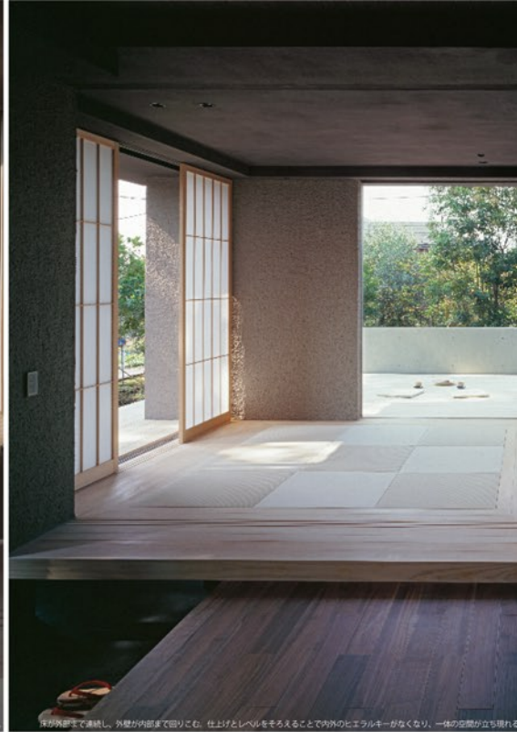
坪が外部まで連続し、外壁が内部まで回り込む。仕上げとレベルをそろえることで内外のヒエラルキーがなくなり、一体の空間が立ち現れる。
