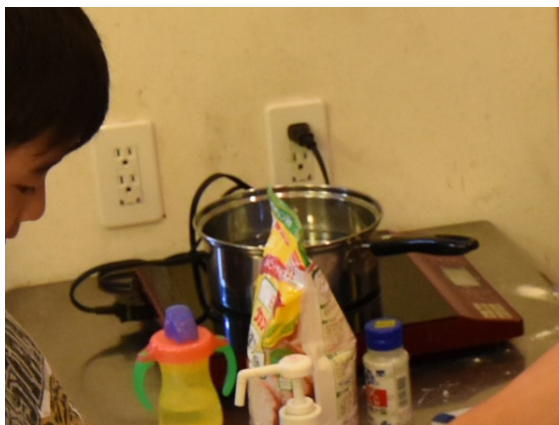
壁面にシャッター付の単独回路コンセント
