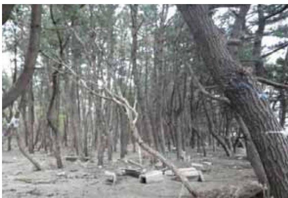
写真-24 クロマツの防潮林(砂、瓦礫が堆積)
