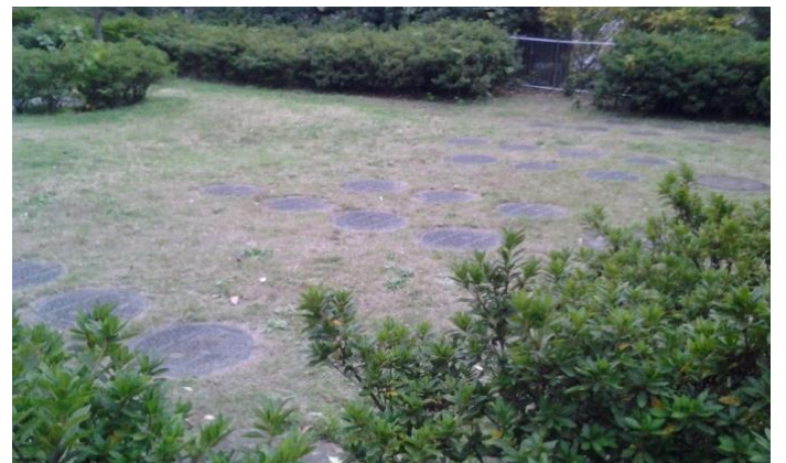
貯水槽兼災害時トイレのための、マンホール
