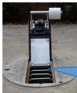
災害用の小型マンホールの上部に仮設のトイレ
