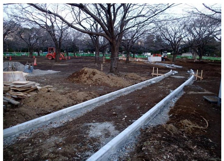
工事中のバーベキューひろば
