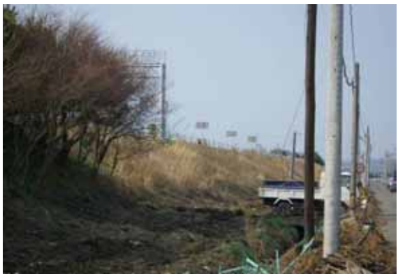
写真-9 東部道路（盛土部分） （高さ約1.5mのところ浸水跡がある）
