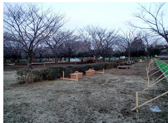
工事中のバーベキューひろばとかまど形ベンチ
