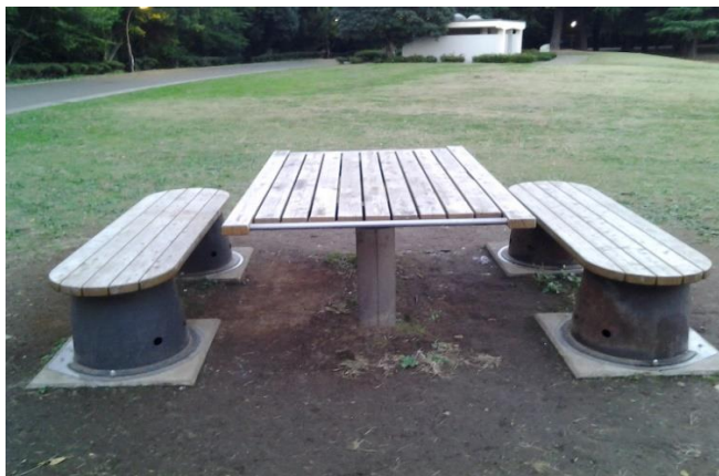
かまどベンチ=普段はベンチとして使用、災害時には座る部分を外し、かまどとして炊き出しなどに用いる。
