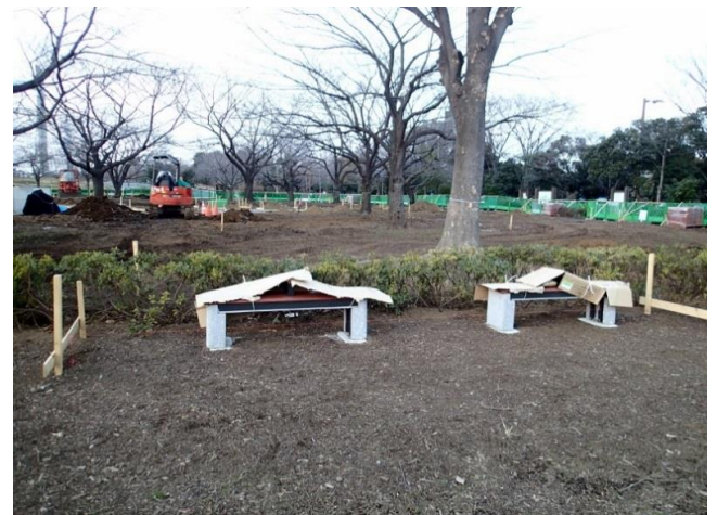
工事中のバーベキューひろばとベンチ
