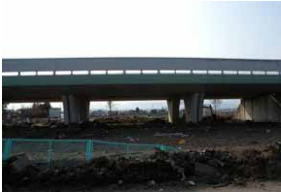
写真-8 東部道路（高架部分）
