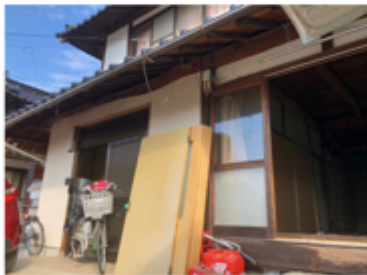
解体工事中写真
