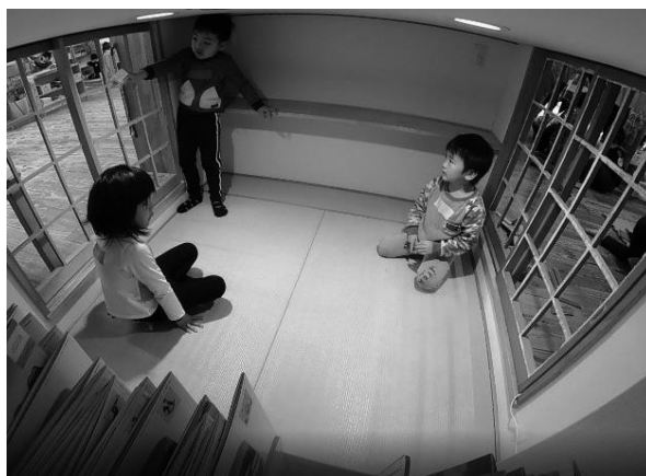
写真 4-9 障子の紙を貼らずに組子だけとした場合
